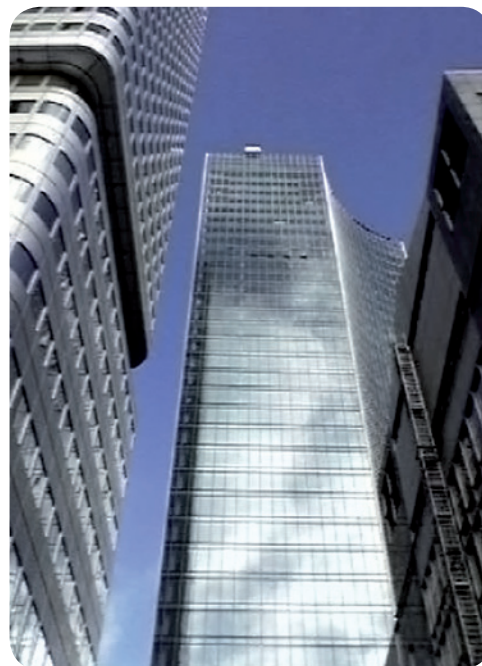
Referenzobjekt Bürohochhaus Skyper, Frankfurt a.M.
